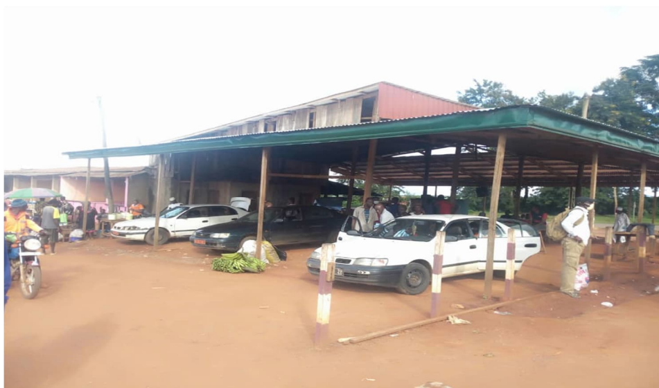
Photo 11 : Gare routière de Mbandjock
